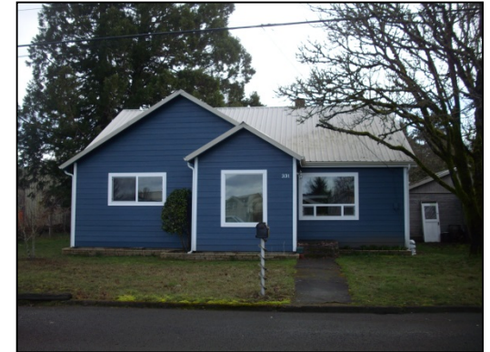
Despues de Remodelación
